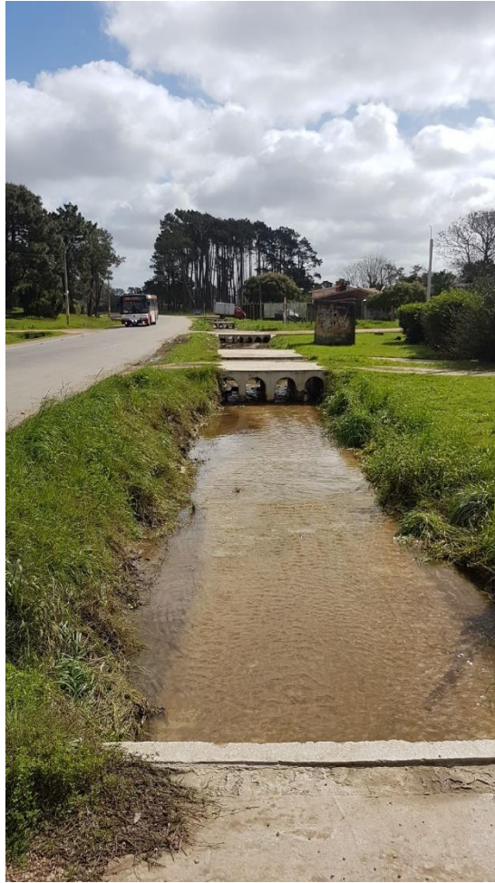
Imagen: Canal Horacio García Lagos (sin vegetación que obstruya sistema de drenaje)
