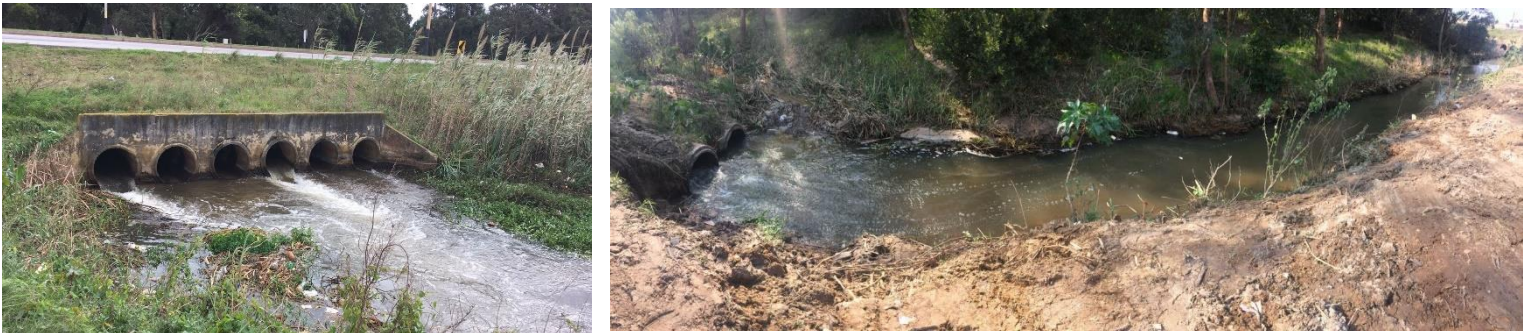
Imagen: Limpieza de descarga del canal Racine
