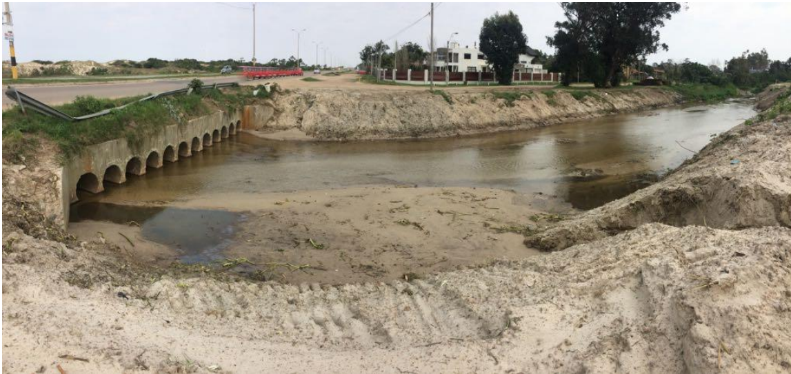
Imagen: Estado del canal Artigas finalizadas las tareas de limpieza y desobstrucción.
