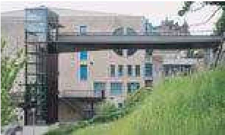
Ascensor público y pasarela peatonal / VAUMM
