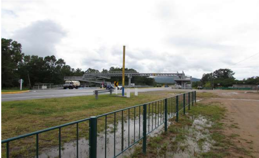
Figura 9: Puente peatonal sobre R.Ib
