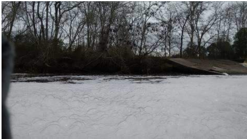
Figura 9.34 Zona del predio inmediatamente aguas debajo de represa. Margen derecha del arroyo
