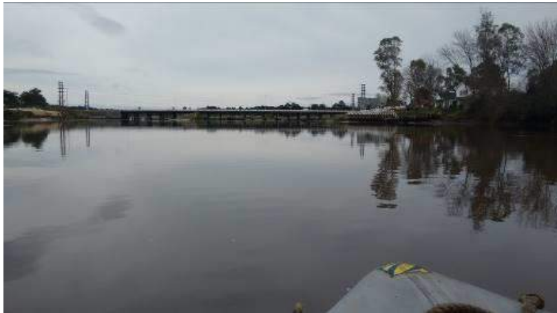
Figura 9.24 Puente sobre la ruta Interbalnearia
