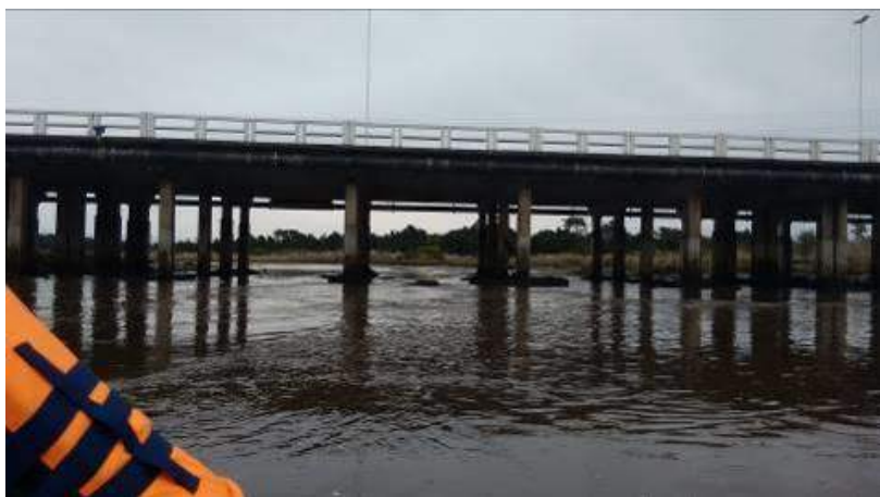
Figura 9.25 Puente sobre la ruta Interbalnearia
