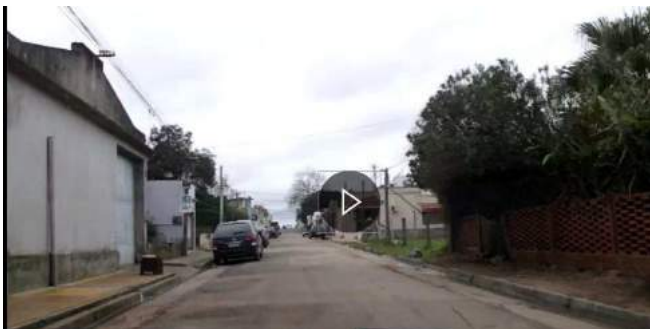
Calle en Sauce con cordón cuneta y vertimientos a la misma
