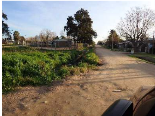
Cuneta frente a escuela
