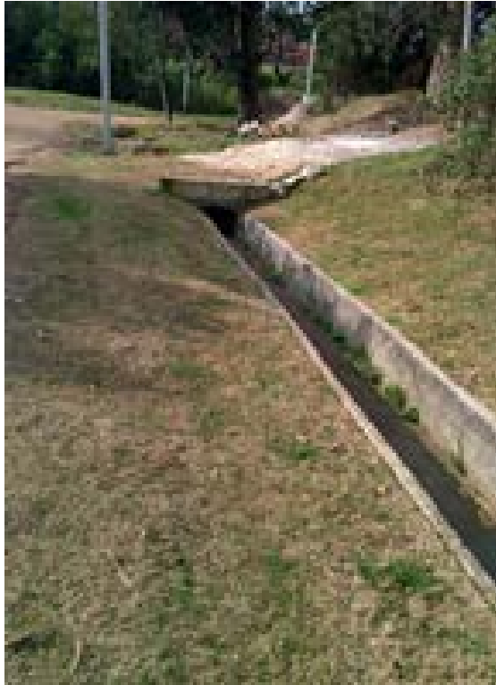
Foto 12: Tramos finales de conducción de canales por vereda sur de calle 14
