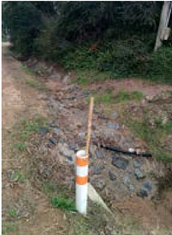
Foto 15: Elementos para evitar erosión a entrada de alcantarilla de cruce de Camino las brujas
