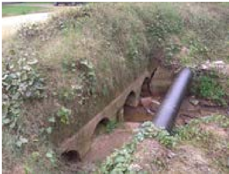
Foto 24: Alcantarilla de cruce Av. Pinares
