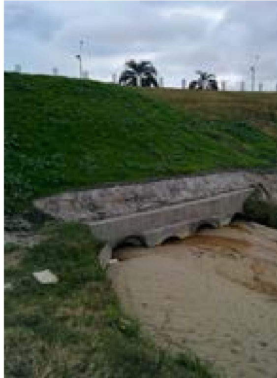
Foto 30 Alcantarilla de cruce de José Gervasio Artigas
