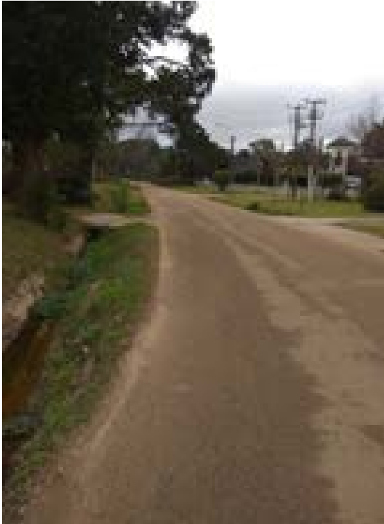
Foto 40 Canal en vereda oeste de Av. Pinares, vista norte.
