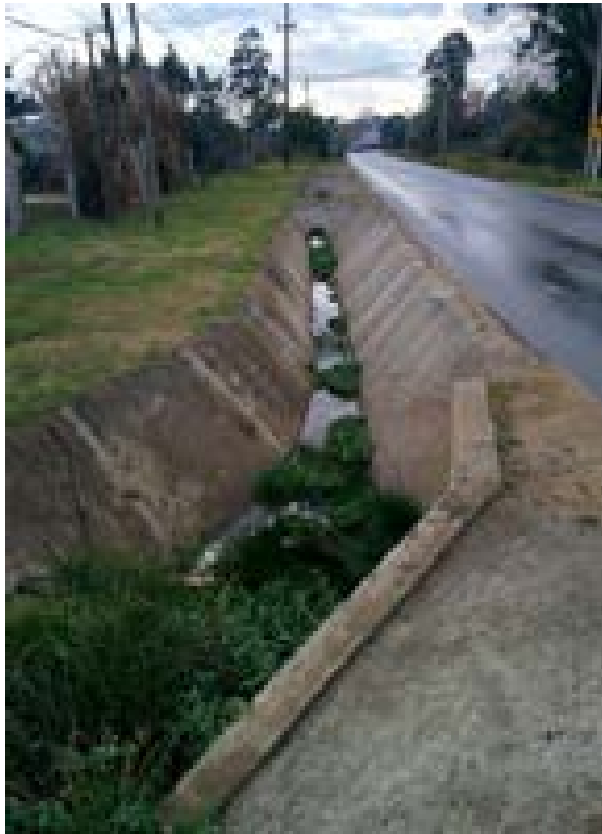
Foto 6: Canal por vereda oeste de calle 18
