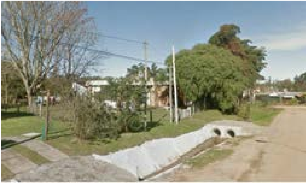
Foto 10: Transición de canal revestido a cuneta empastada vereda norte calle 14 foto desde aguas arriba (foto extraída del Google Earth)
