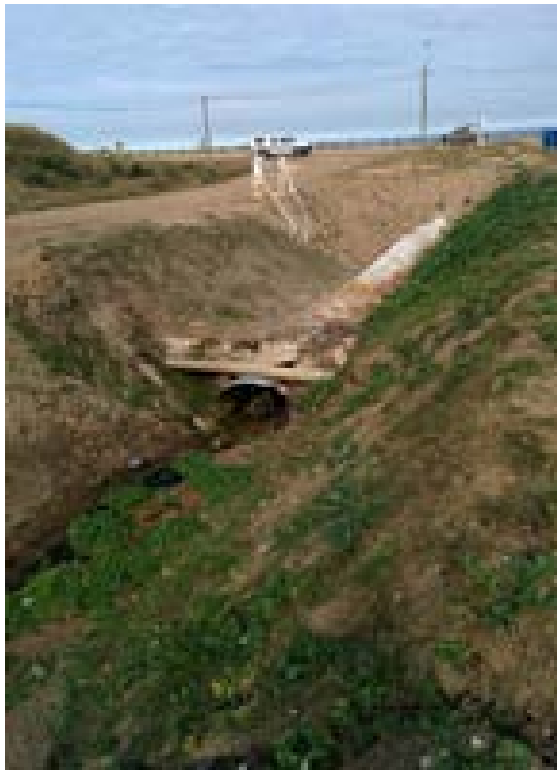
Foto 37 Canalización del cañadón hacia la rambla, vista hacia la rambla
