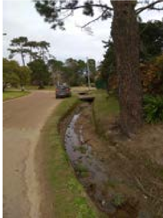
Foto 41 Canal en vereda oeste de Av. Pinares vista hacia el sur.
