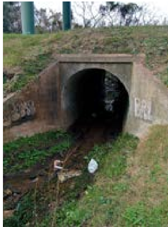
Foto 28 Cruce debajo del puente de la Interbalnearia
