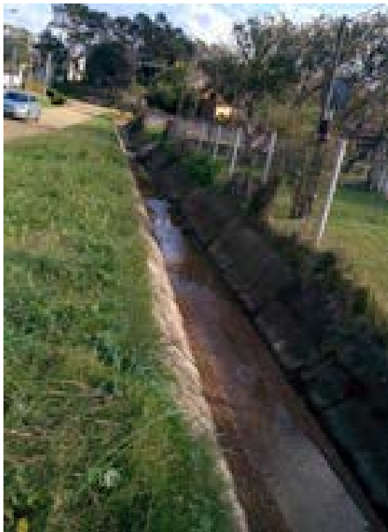
Foto 17: Canal por vereda norte de calle Luisa Luisi
