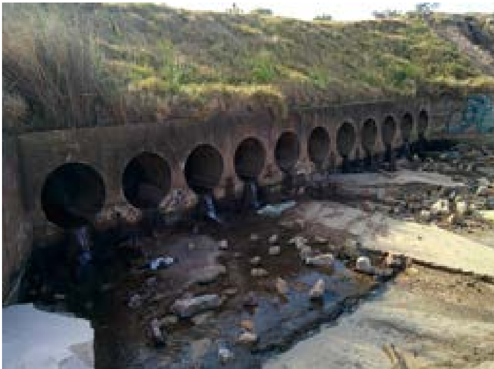
Foto 39 Alcantarilla de descarga a la rambla
