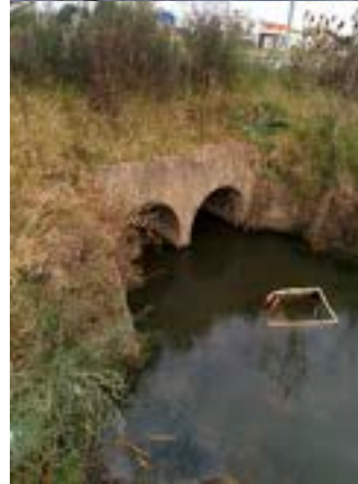
Foto 4: Alcantarilla camino al Parque del Plata (aguas arriba y aguas abajo)
