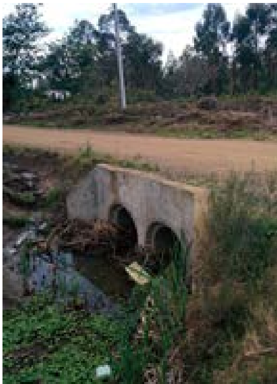
Foto 8: Alcantarilla de cruce de calle 12
