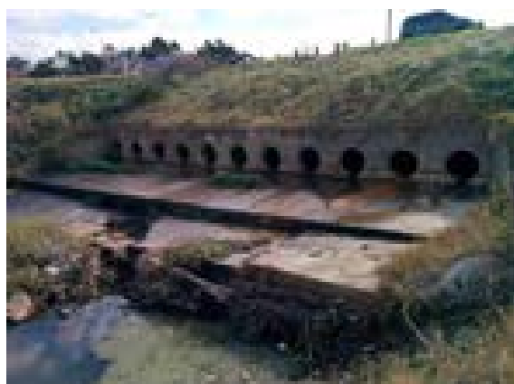
Foto 22: Alcantarilla de cruce de la rambla, foto aguas abajo
