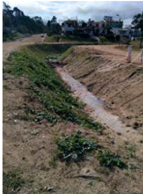
Foto 38 Cañadón trapezoidal y transición a la canalización, visto desde la rambla.
