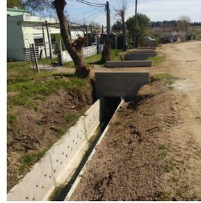
Zona delimitada por las calles Perú - Paralela 7 - Carmelo Colman - Senen Rodríguez. Obra: ejecución de canales "U" de hormigón armado; colectores pluviales subterráneos y cámaras de hormigón armado; limpieza y conformación de cunetas: cruces y entradas vehiculares.
