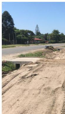
La Dirección General de Obras está trabajando en la resolución de un problema hidráulico en la calle James Summer en Solymar. Las obras previstas incluyen la construcción de un colector pluvial en Márquez Castro entre Summer y Acacias. El colector pluvial se conectará al macrocanal recientemente construido y permitirá la efectiva conducción de pluviales hacia la faja costera.
