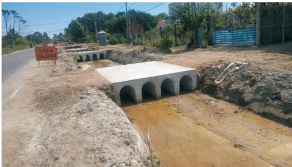
OSE va a demorar en llegar, la Intendencia de Canelones decidió adelantar las obras de drenaje pluvial previstas para la zona, a través de la construcción de cunetas y canales para la conducción de aguas de lluvia. En cuanto al componente vialidad, se está haciendo el recargo de las calles en tosca, reperfilándolas con un punto más
