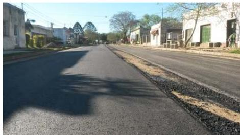
El paquete estructural de la calle en el perfil urbano consta de una capa de base de material granular compactado y una capa de rodadura que dependerá de la jerarquización vial de cada calle. En todos los casos este perfil se complementa con la construcción de cordón cuneta y badenes para la correcta evacuación de aguas pluviales. La calle Avda a La Estación (jerarquización intermedia) consta de una base de tosca compactada
