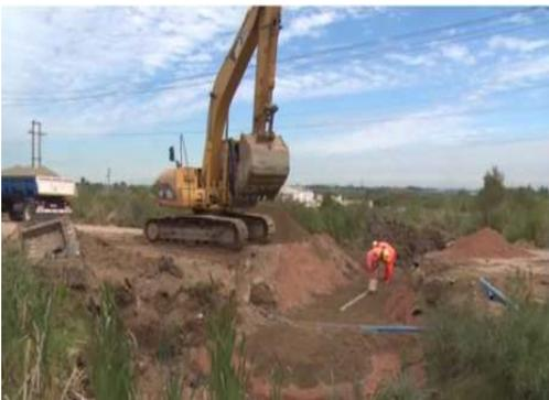
Esta zona de perfil rural con cunetas a cielo abierto contará con un paquete estructural de 40 cm de tosca, continuando con una base segmentada para
