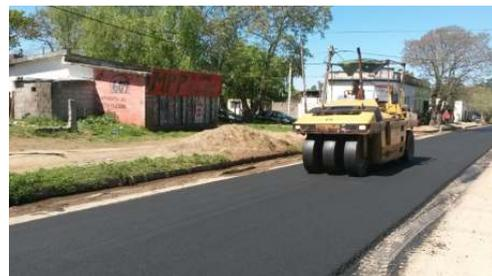
En las otras calles (jerarquización interna) la capa de tosca será de 30cm compactada y se ejecutará una carpeta de rodadura de tratamiento bituminoso según las exigencias del caso.
