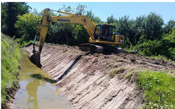
En el Municipio de Santa Rosa, sobre camino Briñoni, Paraje La Paloma, se está trabajando en una obra hidráulica de colocación de alcantarilla, son cinco bocas con caños de 1 m de diámetro. La obra se ejecuta en sustitución del antiguo puente que estaba muy deteriorado.
