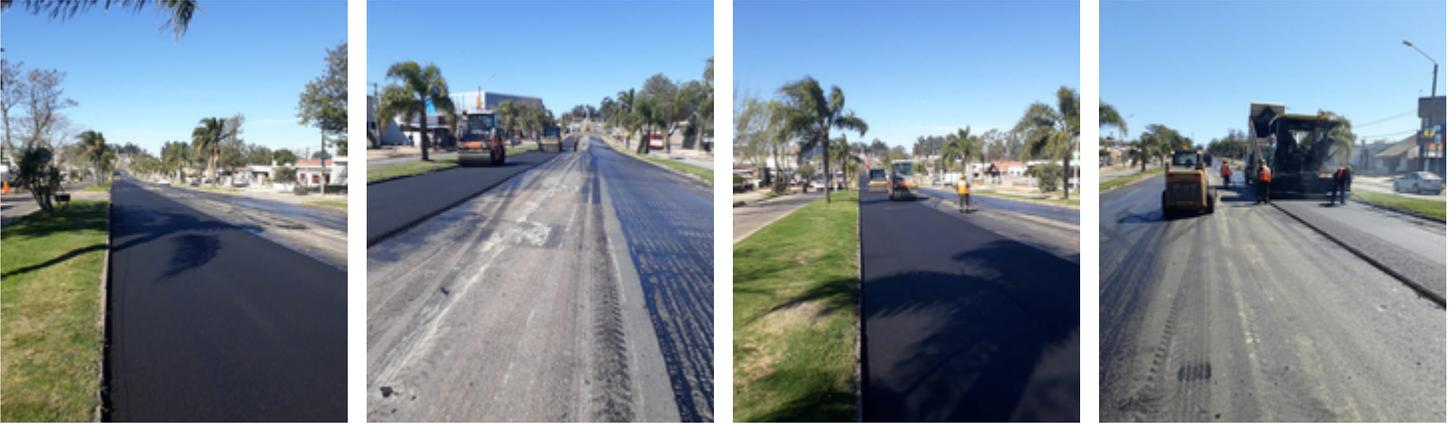
Avanzan las obras de rehabilitación de pavimento que se están ejecutando sobre Av. Bicentenario desde Rep. Argentina hasta la rotonda del Obelisco. En la avenida central y las calles laterales se ejecuta fresado, bacheo y recapado con mezcla asfáltica.
