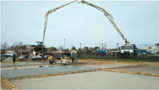
Se desarrollan a buen ritmo las obras de construcción de una pista de patín en Barrio Norte del Municipio de Progreso. Se tratará de una plataforma de hormigón armado con banco perimetral, de 30 m por 17 m en total.
