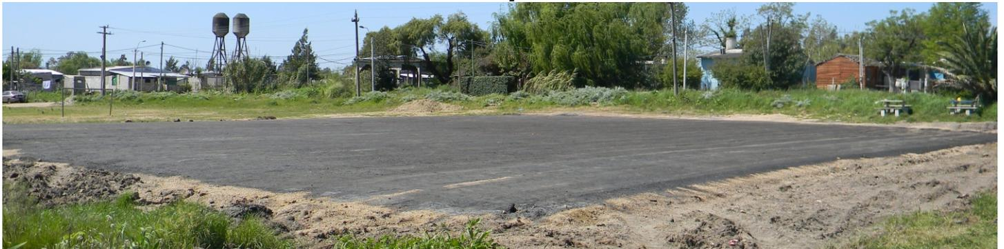
En Villa La Colina del Municipio de Barros Blancos se está construyendo una cancha polifuncional doble (de 42 m x 30 m). Al momento ya se realizó la imprimación de la cancha; próximamente se dará paso a la ejecución de la carpeta asfáltica y finalmente se realizará la terminación y pintura de la cancha y líneas. El financiamiento de esta obra se realiza con fondos de la Intendencia de Canelones. La obra se ejecuta por contrato adjudicado mediante licitación abreviada a la empresa Idalar S.A.
