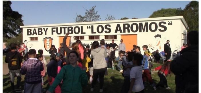
El Club de Baby Fútbol Los Aromos de Nicolich ya disfruta de su nueva sede: un salón multiuso con un área de 132 m<sup>2</sup>, construido con estructura de hormigón armado, muros de mampostería revocada y cubierta de Isopanel. En el exterior a la edificación se construyó una rampa que asegura la accesibilidad universal al predio y al local.
