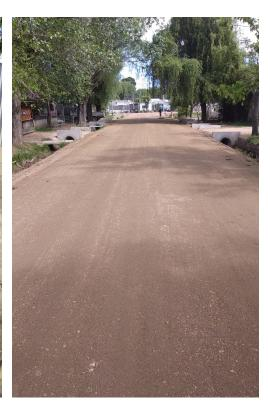
3.600 m de tratamiento bituminoso doble con sellado; limpieza y/o conformación de cunetas; pluviales de caños de hormigón con cabezales en cruces de calles, entradas particulares y peatonales; señalización vial; adecuación de alumbrado.
