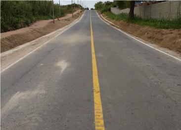
Detalle de la obra: 1360 m de pavimento de carpeta asfáltica, cunetas; entradas particulares; construcción de senda peatonal en zona de canteras; señalización vial; adecuación de alumbrado. Inicio de obra: Junio de 2018 - Monto estimado: \$ 17.000.000
