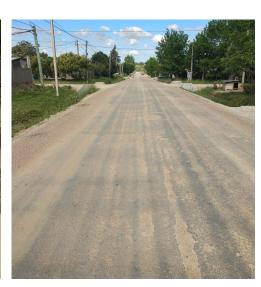
Detalle de la obra: 94 cuadras de tratamiento bituminoso doble; 24 cuadras de carpeta asfáltica; limpieza y conformación de cunetas para la conducción de pluviales; cruces de calle; entradas domiciliarias; señalización vial.
