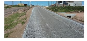
Se realizó la obra de pavimentación en la calle de doble vía Martín Céspedes. Se colocó tratamiento bituminoso doble con sellado (TBDS) en un área de 3.560m2.
